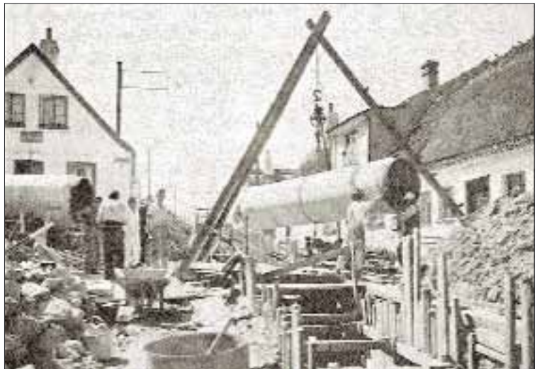
Vandledningen fra Lejreværket til København lægges i 1936. Foto fra: Arthur Fang, Sct. Jørgensbjerg
