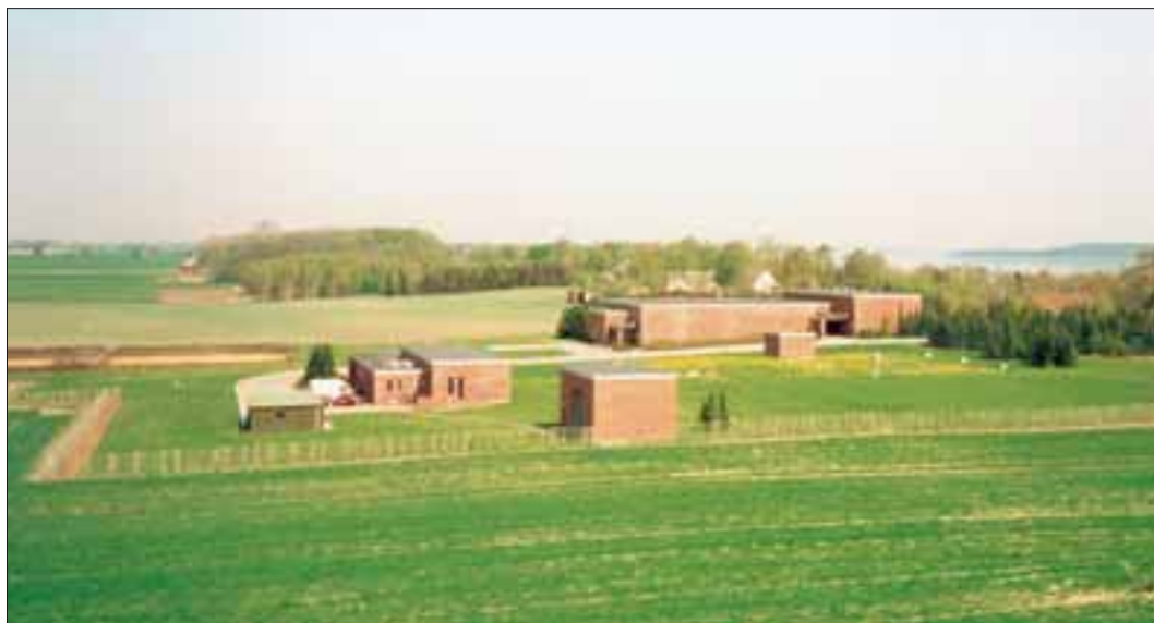
Hornsherredværket. Forrest hydroforbygningen, lidt til venstre maskinbygningen og bagest filterhallen og iltningstårnet.
