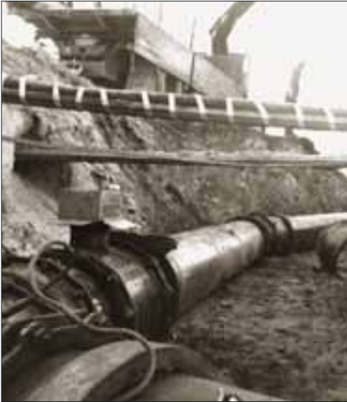
Rørlægning af de mange km hovedledning blev udført af Vandforsyningen eget personale.
