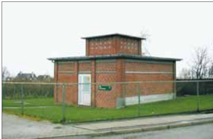
Veddelev Vandværk er fra begyndelsen af 1960'erne. Foto fra »Vandforsyningsplanen 2002-2012«.
