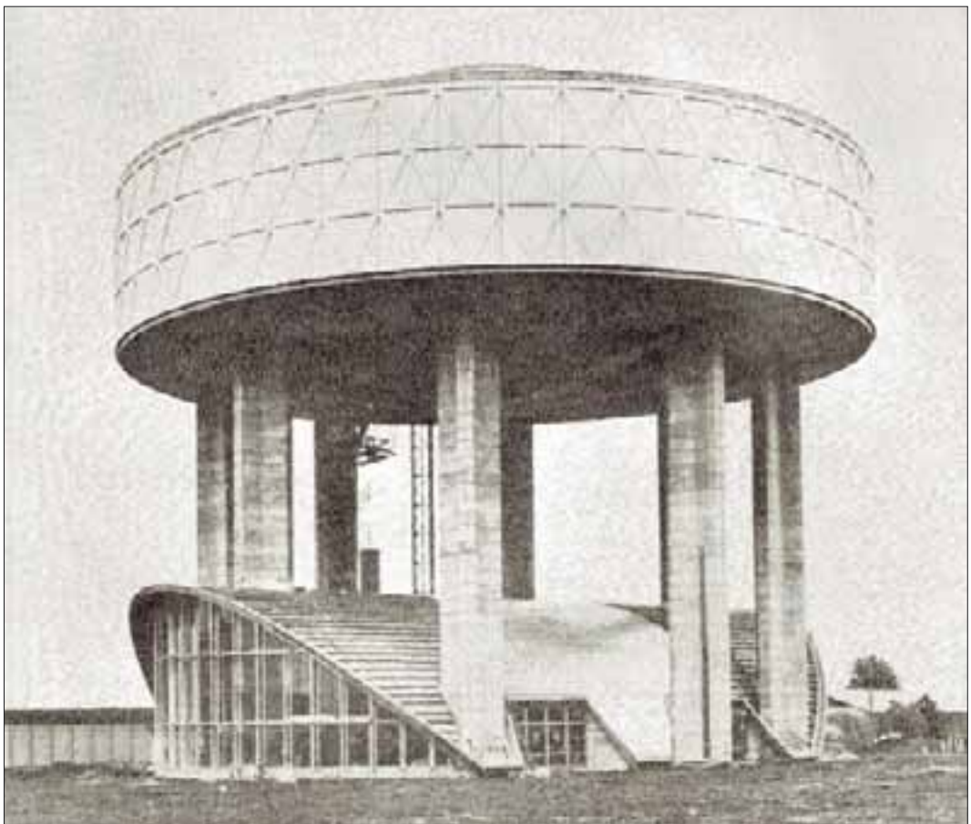
Det færdige vandtårn. Man ser tydeligt på søjlerne, hvordan bunden er blevet løftet op i etaper 60 cm ad gangen. Foto fra Stads- og Havneingeniøren nr. 9, 1960.
