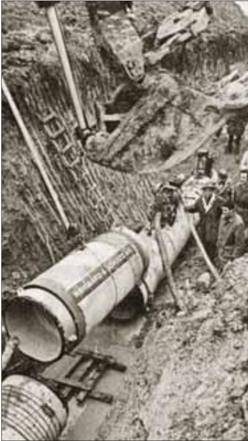
Det sidste rørstykke af Bonnarørsledningen sænkes ned. Foto fra Roskilde Tidende 21.12.72.
