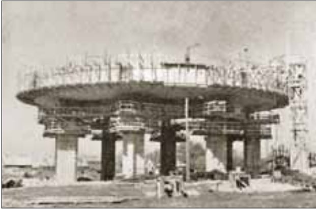
Vandtårnets bund under løftningen med donkrafte og samtidig støbning af søjlerne. Foto: »Stads- og havneingeniøren« nr. 9, 1960.
