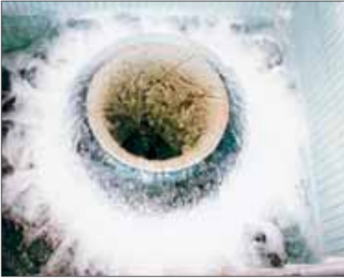
Indløbet af det klare og rene drikkevand i rentvandsbeholderen.
