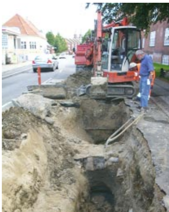
Renovering af kloak i Helligkorsvej
